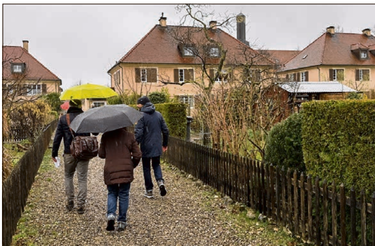
Unterwegs im Freidorf: In der Welt bekannt und geachtet, ist die 75'000 Quadratmeter grosse Siedlung bis heute ein Beispiel für gute Baukultur.
