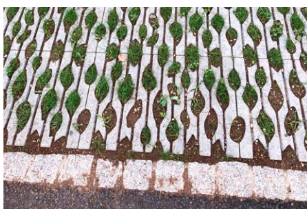
Einfach, aber wirksam: Rasengittersteine mit grossem Fugenteil.
