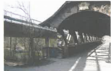
Verbindungsstrasse nach Neumünchenstein: neue und alte Brücke
