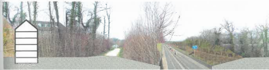
Übergang Siedlungsgebiet – Fluss- raum: Lage der Autobahn unterhalb der Hochterrassenkante
