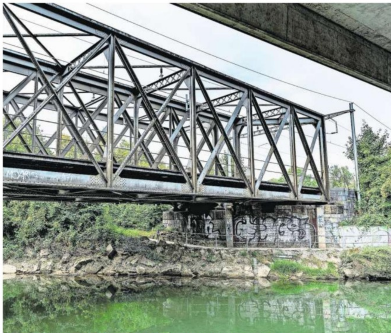
Vom Kanton als schützenswert eingestuft: Die hundertjährigen Stahlfachwerkbrücken in Münchenstein.
