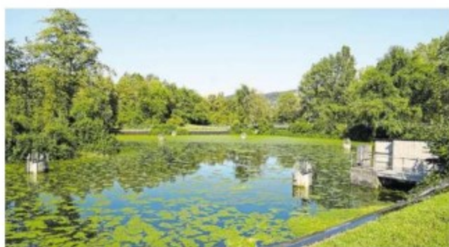
Klares Wasser für Aesch: Mit der Grundwasseranreicherungsanlage wird die Trinkwassergewinnung auch in Trockenzeiten sichergestellt.
