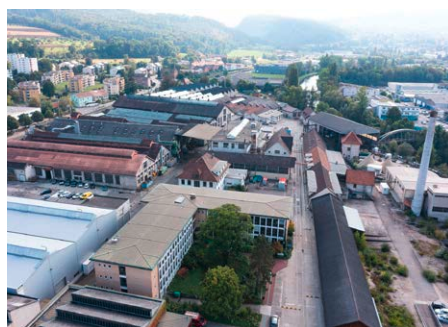
Das Areal Wydeneck Dornach wurde für zehn Jahre in eine Zwischennutzung freigegeben.
