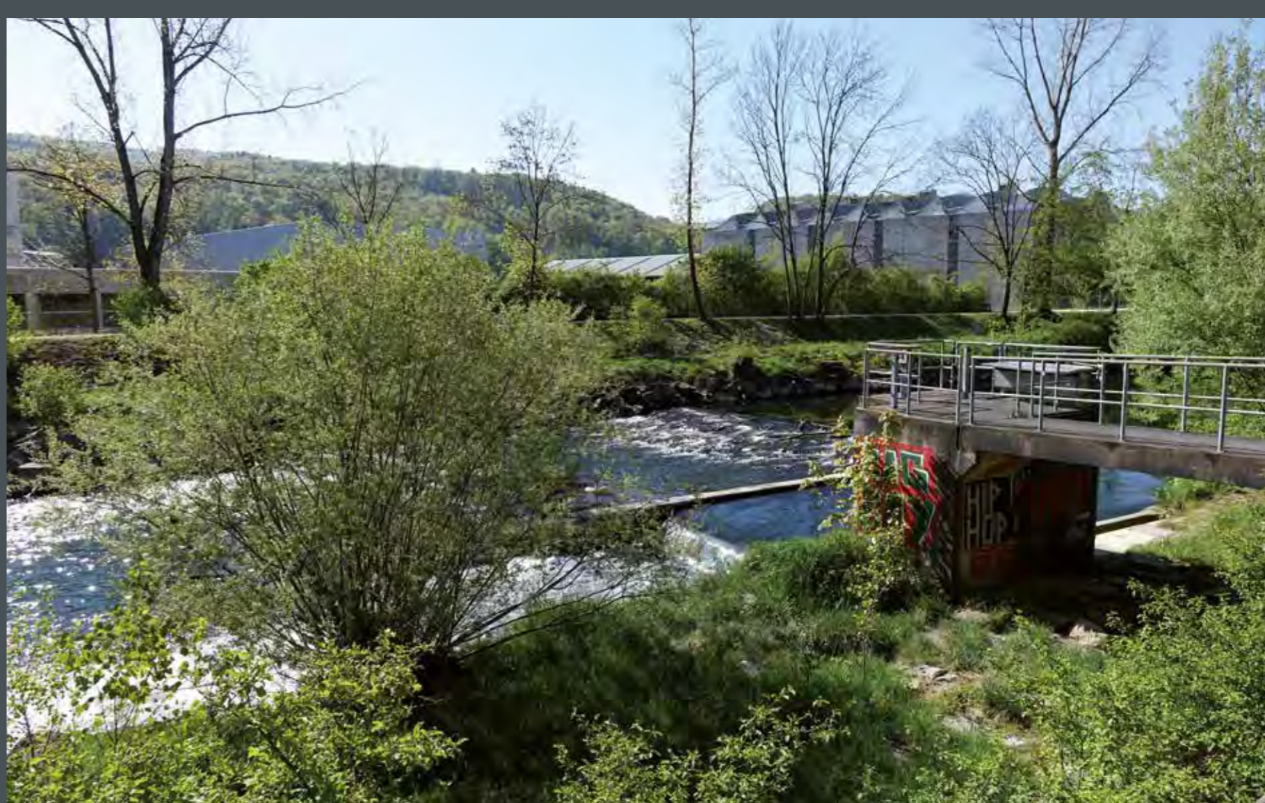
Die Rohwasserfassung auf der anderen Uferseite (mit Infotafel bei Pumpwerk).
