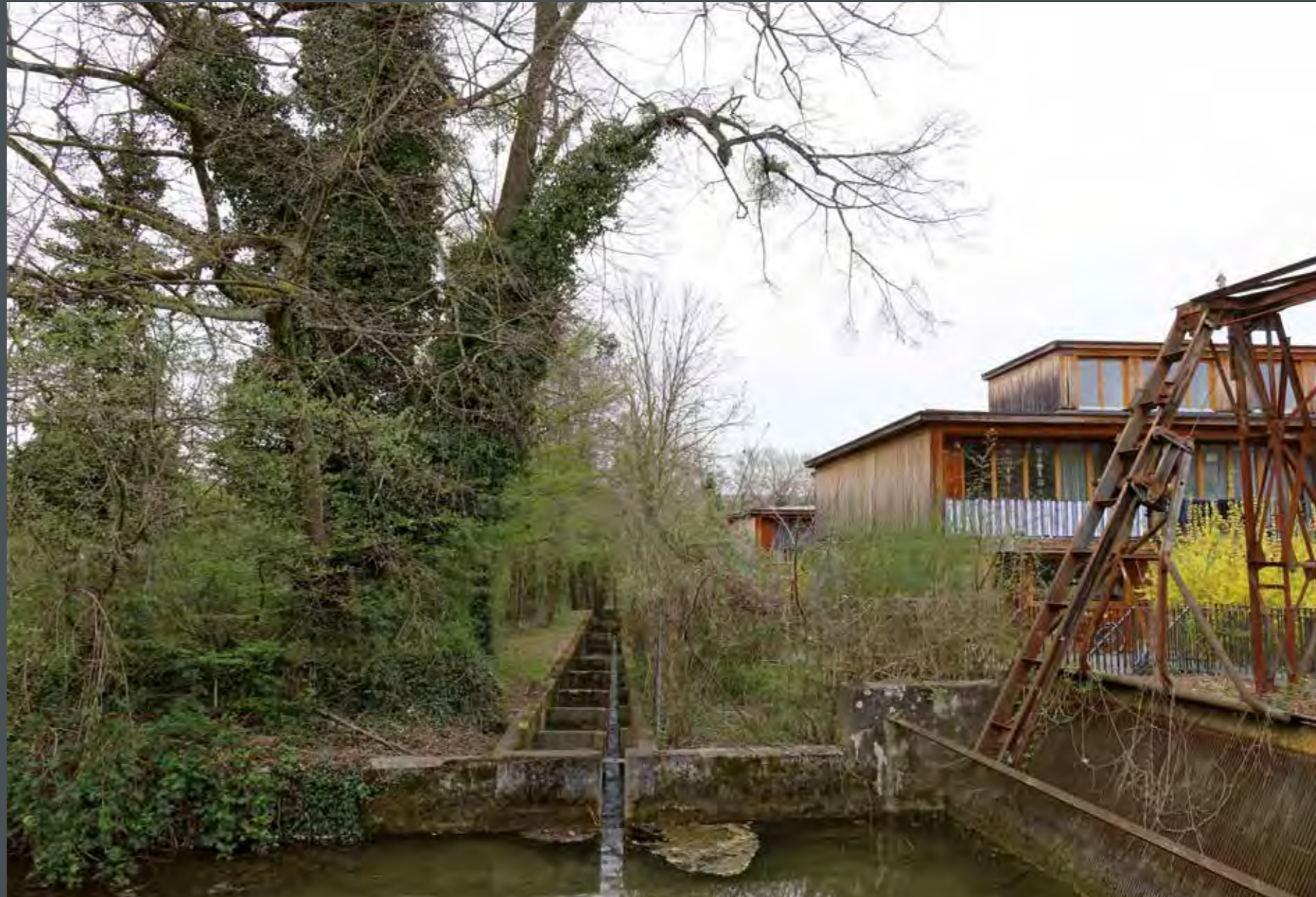
Der früher zur hydraulischen Energiegewinnung genutzte Schappe-Gewerbeanal dient heute als Umwegungsgewässer mit Fischtreppen.
