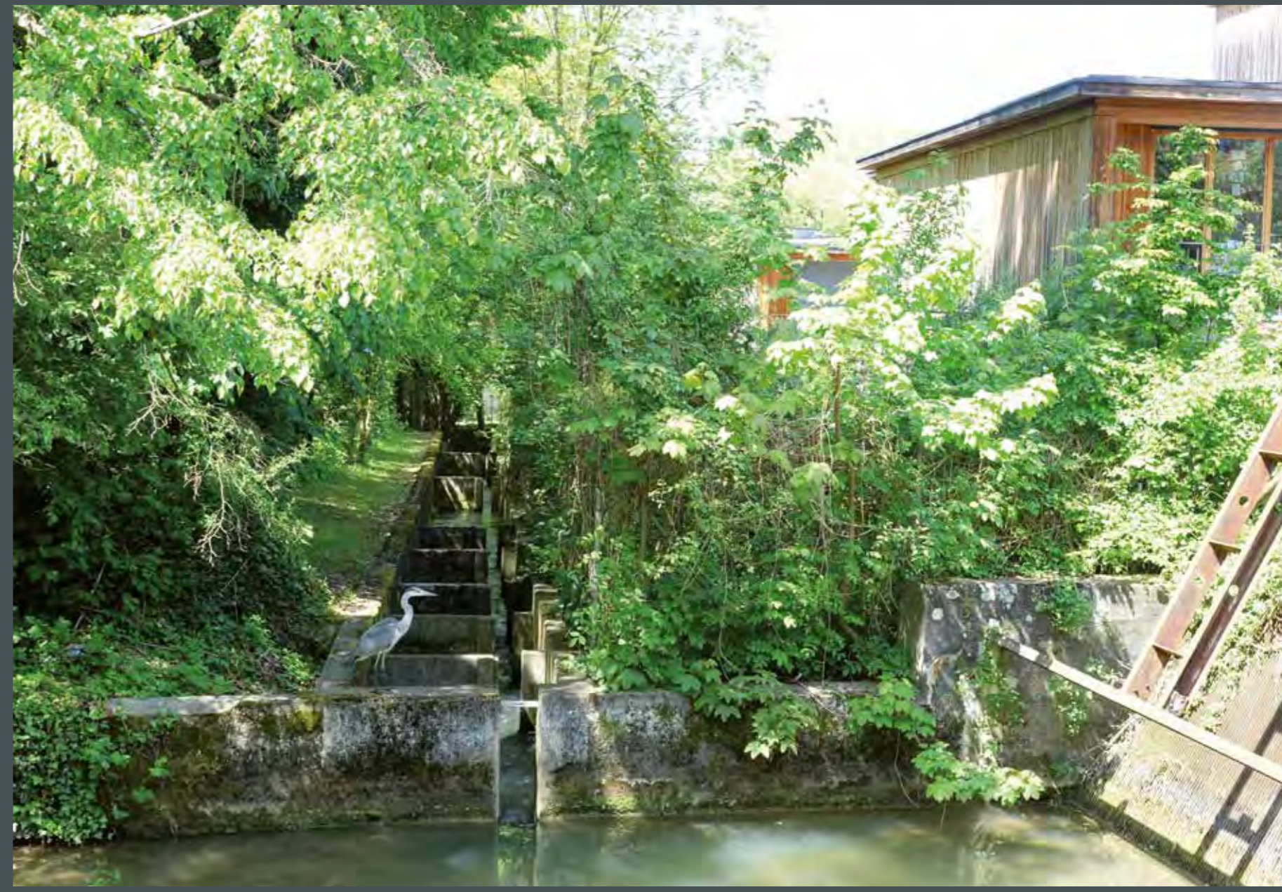
Beim Einlaufbauwerk (rechts) endet heute der alte Schappekanal. Der frühere Überlaufkanal (links) ist zur Fischtreppe ausgebaut worden.
