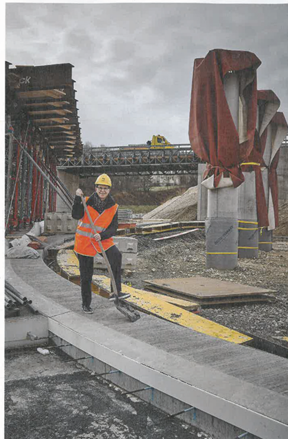
Der Verein Birsstadt hat auch gegenüber dem Kanton eine stärkere Stimme. Franziska Stadelmann auf der Baustelle des A18-Anschlusses in Aesch.
