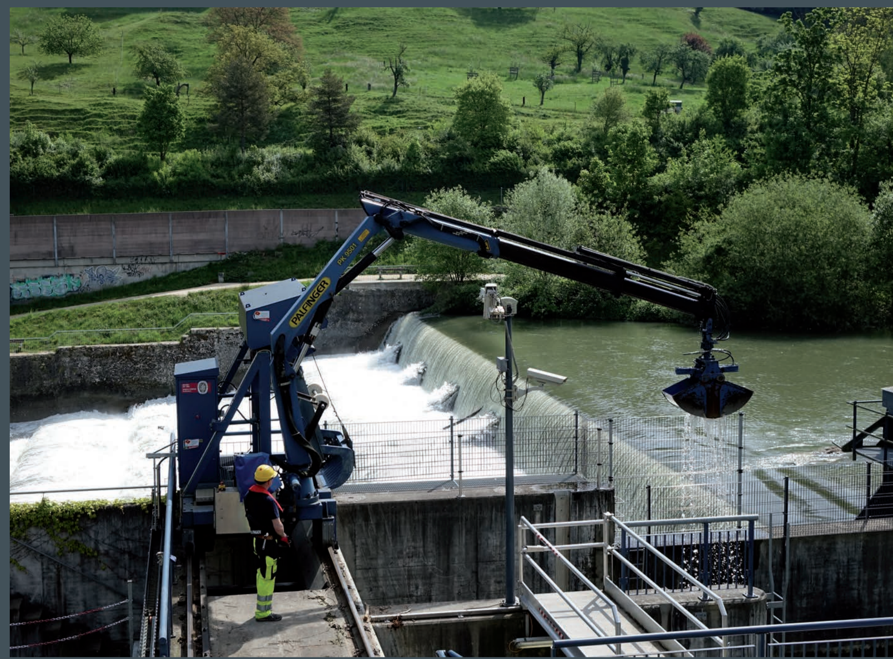
Der Wasser-Einlaufkanal muss regelmässig ausgebaggert werden.
